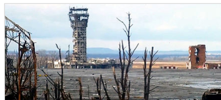
La tour de contrôle de l'aéroport de Donetsk endommagée par les combats, en décembre 2014.
